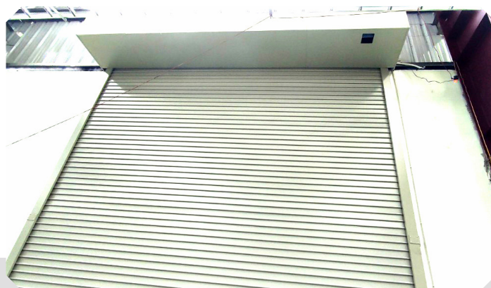
CỬA CUỐN NGẮN CHÁY GIỚI HẠN CHỊU LỬA E120 KCCC1
